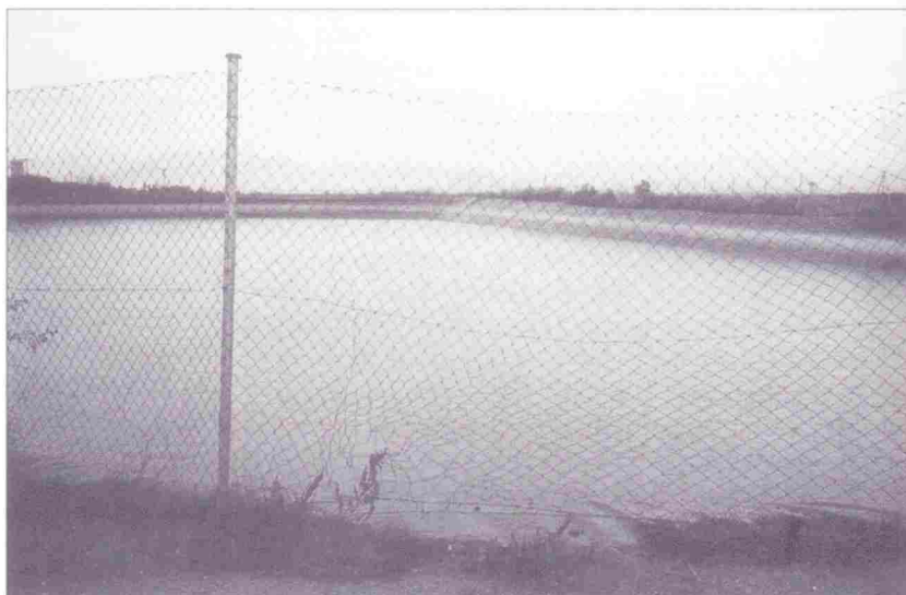
Existe otra pantaneta en Gabia Chica, paraje del Agramazón, para el almacenamiento del agua de los pozos durante la noche
